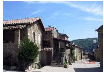
Rue de Boucieu
